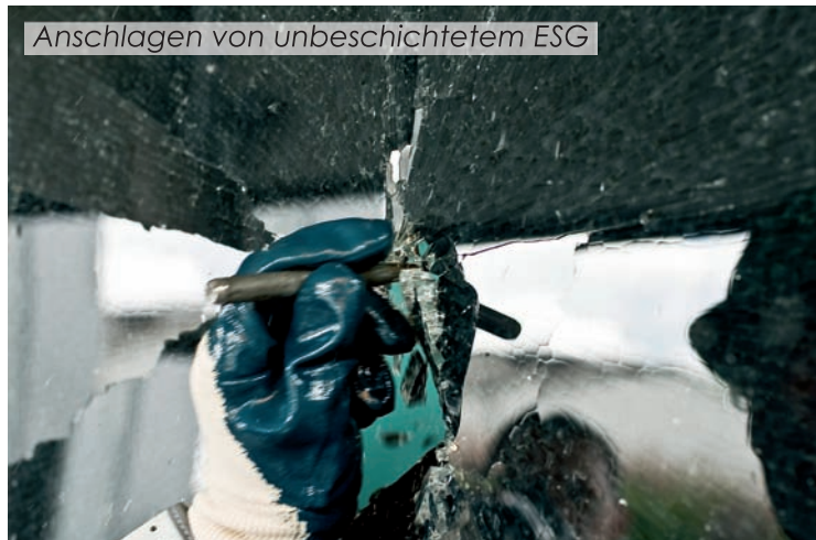
Anschlagen von ESG mit Sicherheitsschicht HG-MP2008 Liquid Safe
