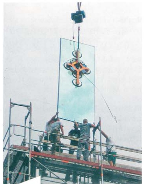
Montage großer ISO-Elemente in Hamburg
