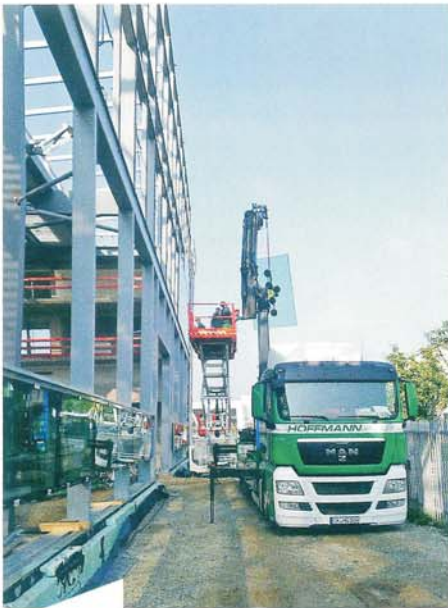
Montage in Göttingen mit dem 22 m Auslegerkran
