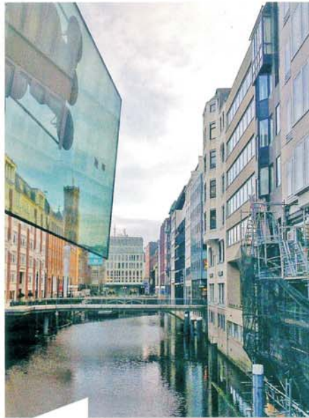
Aufwendiger Scheibeneinbau über Wasser in Hamburg
