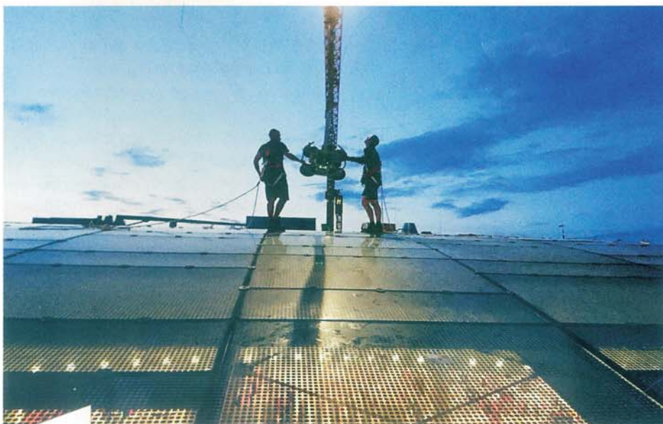
Der Glasspezialist setzt auch auf eigene Montageteams: Hier eine Glasdachmontage in Leipzig
