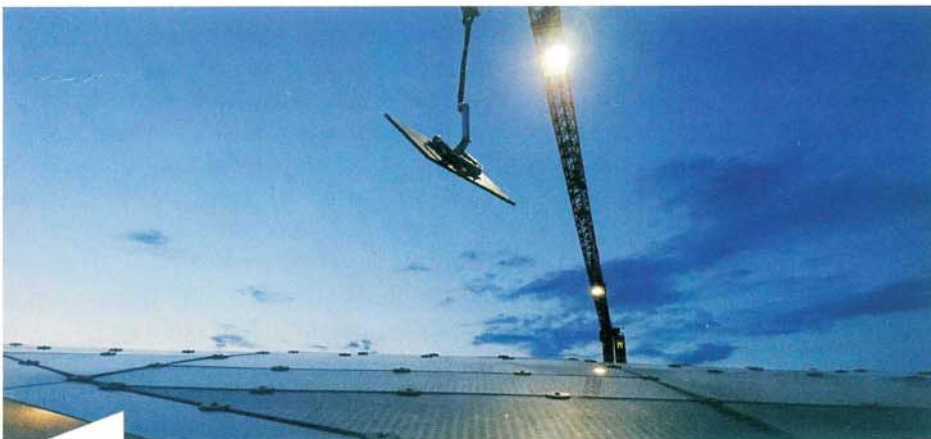
In Großstädten ist das Zeitfenster für die Montage oft sehr eng oder muss wie hier in den Abendstunden erfolgen.
